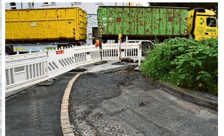
Kantsteine für den Kreisverkehr sind schon gesetzt.
